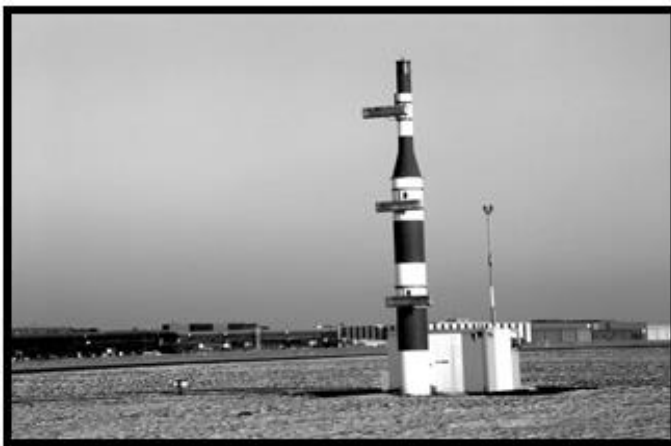
شکل ۵ - ایستگاه glide slope ، فرودگاه هانوفر آلمان
